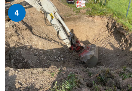
4 Ausheben des Lochs
